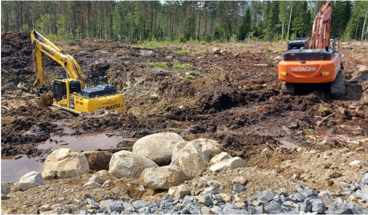
Kuva 1. Kaivinkoneiden ja maansiirtoautojen käyttödata voi auttaa työmaakohtaisten CO 2 -päästöjen laskennassa. Kuva: Nordic Revenium Oy, käytetty luvalla.
